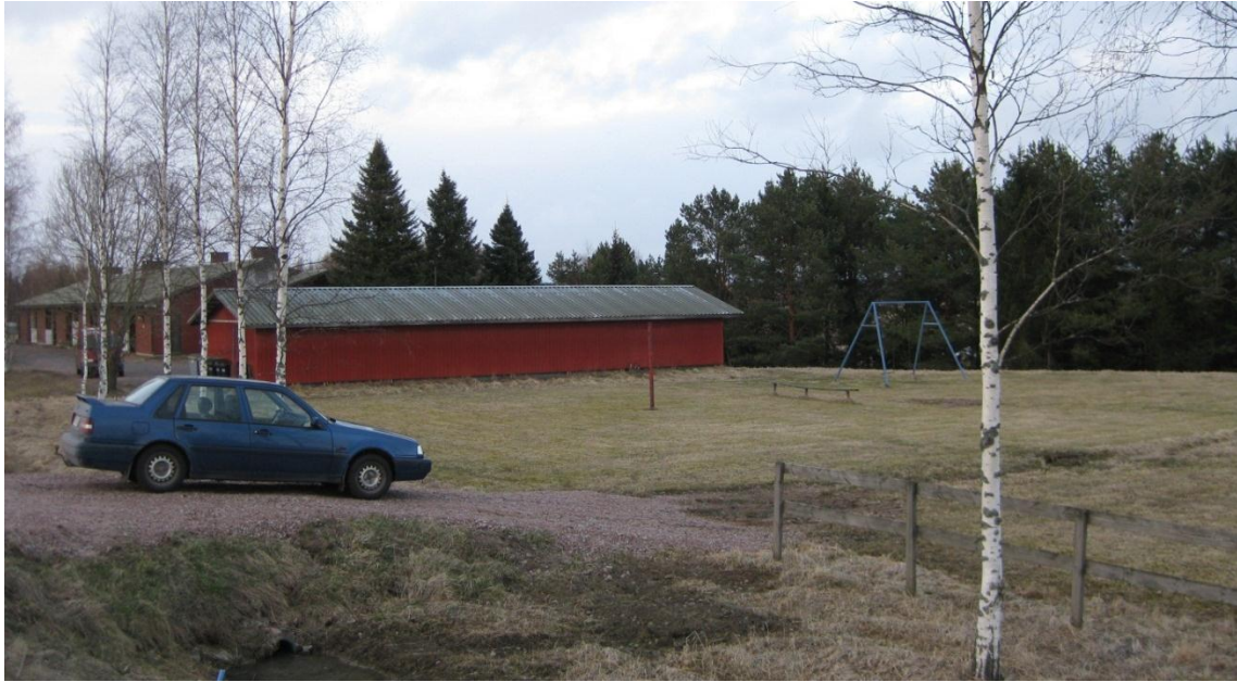
KUVA 1: UUSI LIITTYMÄ PUISTOALUEELLE
